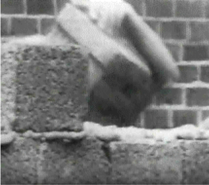
La construction du mur
